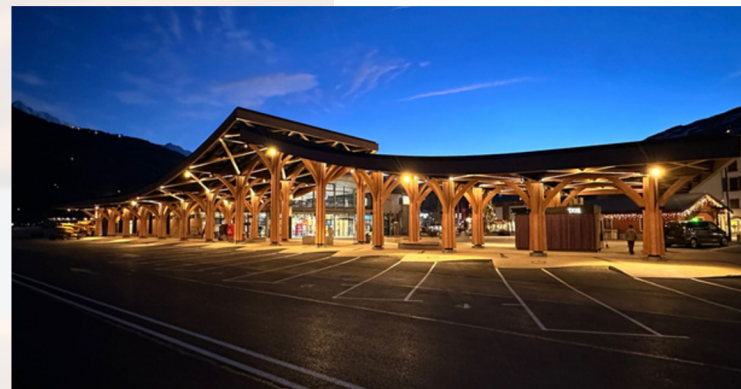
Pôle gare de Bourg-Saint-Maurice (73) — charpente en Douglas français, sortant des scieries MS BOIS
