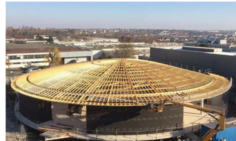
Intersport France à Longjumeau (91) par Cruard Charpente Construction Bois - Charpente en épicéa massif et Lamellé collé français MS BOIS
